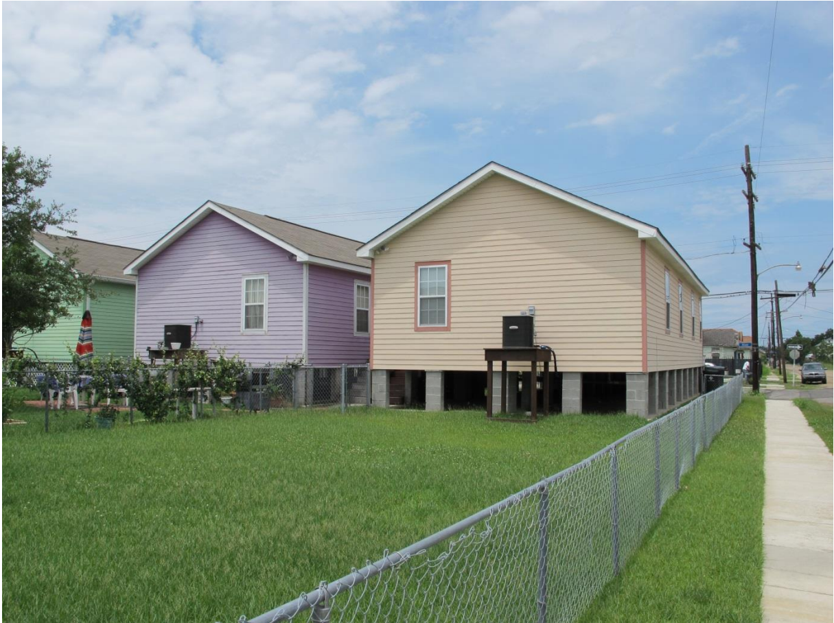
Rysunek 12 Domy o podniesionym poziomie parteru (powyżej lustra wody powodziowej), o konstrukcji pozwalającej na swobodny przepływ wody w czasie powodzi, Nowy Orlean, zabudowa po huraganie Katrina. Fot. M. Arczyńska.
