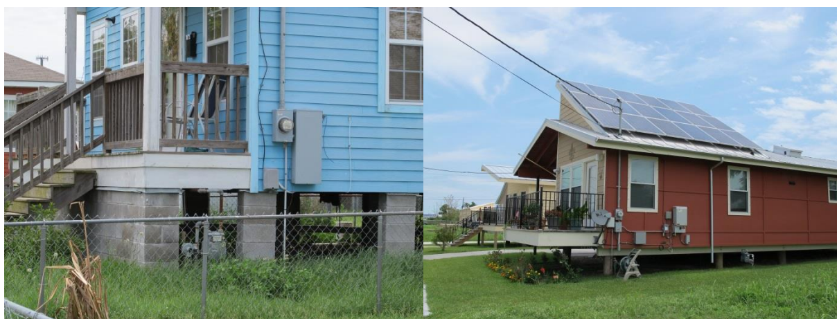
Rysunek 15 Liczniki i przyłącza powyżej poziomu lustra wody powodziowej, Nowy Orlean, nowe realizacje po huraganie Katrina.
