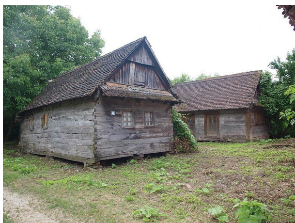
Rysunek 1 Tradycyjne drewniane chaty we wsi Krapje na terenach zalewowych w Lonjsko Polje w Chorwacji. Najstarsze z nich, ok. 200-letnie, budowano na drewnianych palach lub kamiennych słupkach, które później wykonywano z cegły, Fot. Frka
