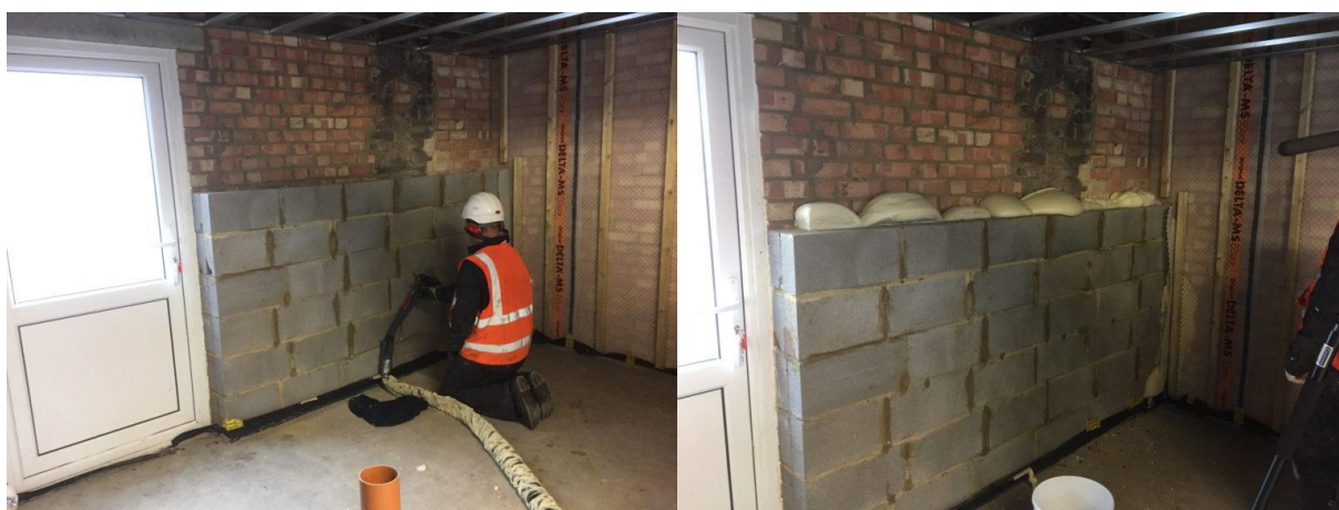
Rysunek 9 Materiał izolacyjny Technitherm® aplikowany in situ w ścianach murowanych, w pustce powietrznej - pianka poliuretanowa o zamkniętych komórkach pompowana do pustki w ścianach warstwowych jako ciecz, która następnie rozszerza i zestala, tworząc sprężysty materiał. Źródło: www.isothane.com
