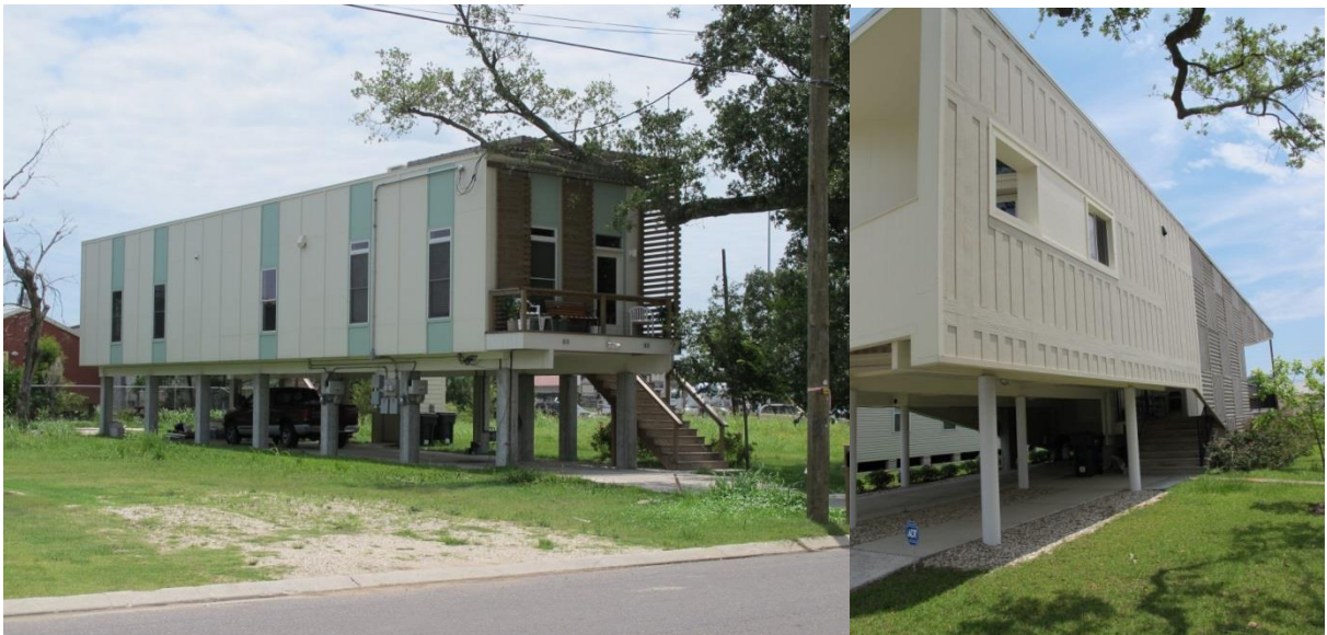
Rysunek 13 Wolna przestrzeń lub miejsce postojowe pod podniesioną częścią domu, Nowy Orlean, po huraganie Katrina. Fot. M. Arczyńska. Nowy Orlean, zabudowa po huraganie Katrina. Fot. M. Arczyńska.
